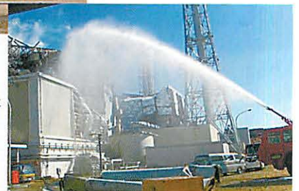
原子炉に対して放水活動を行う消防車A-MB-3
