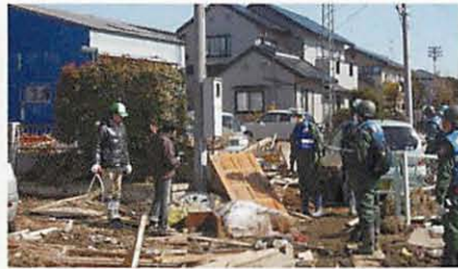
建物の倒壊が激しい地域で地元の方々とともにがれきの除去を行う隊員たち
