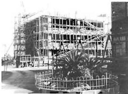
昭和42年12月 工事風景
