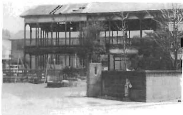
解体中の木造2階建校舎
