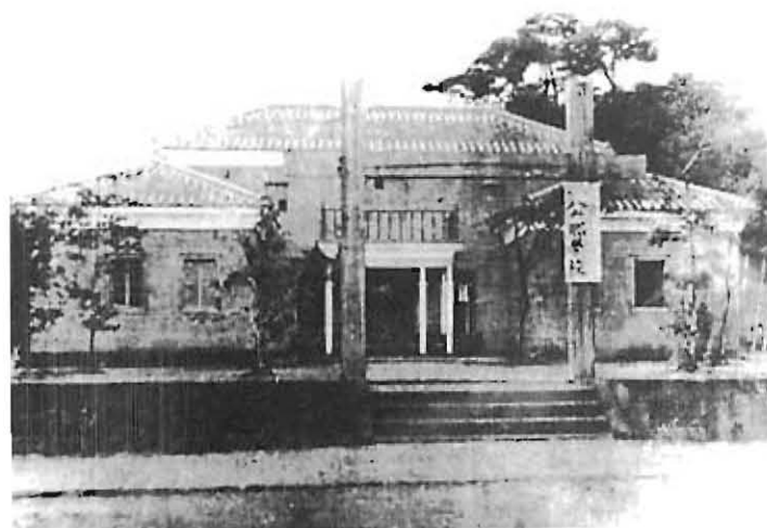
2階建瓦ぶき洋風建築の公郷学校
