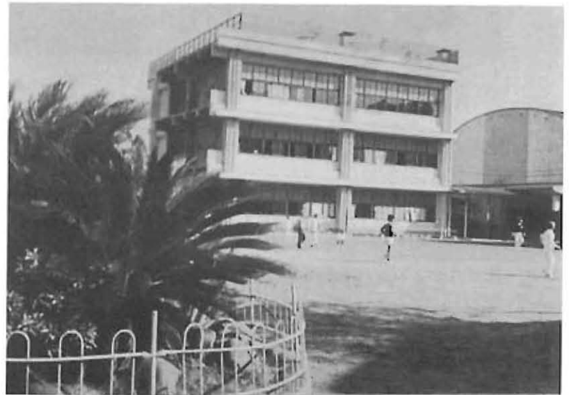
昭和43年3月 完成した3階建鉄筋校舎と広くなった校庭
