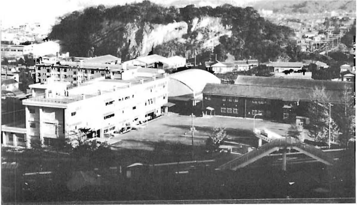
完成した鉄筋校舎と木造校舎（昭和50年頃）
