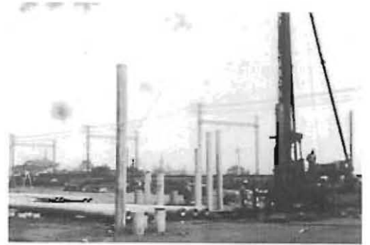
基礎杭打ちの様子
