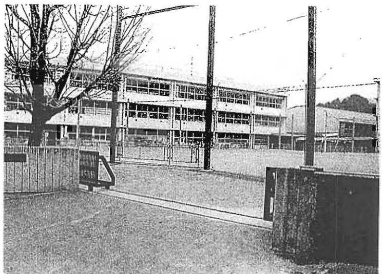
昭和54年完成した校舎
