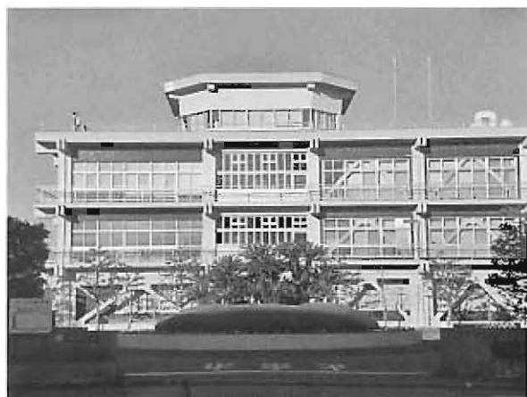
下町浄化センター
