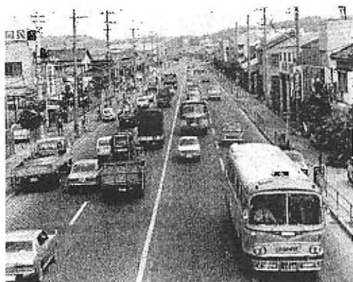
国道16号（昭和47年）
